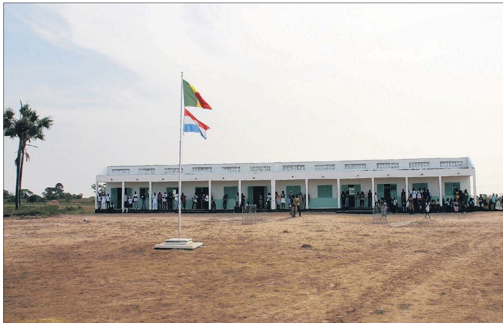
De nieuwe middelbare school op Ile de Mar in Senegal.
